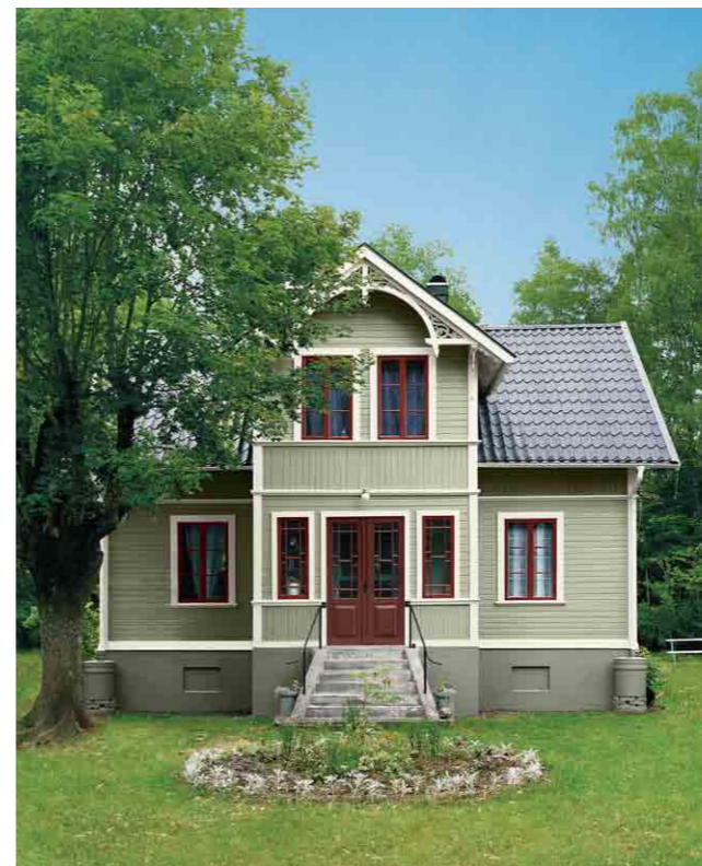
287 Ask Den blekt gulgröna fasadfärgen får en mild men tydlig kontrast mot detaljerna i brunrött och brutet vitt. De smärutiga verandafönstren och snickarglädjen under taket framträder utan att dominera.
