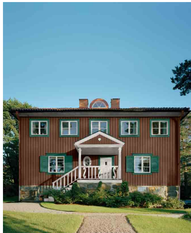
180 Espresso Det här 20-talshuset har fått gröna fönsterfoder och fönsterluckor, medan det vita markerar förstuvkisten och entrén. Om fasaden är mörk är det viktigt att inte ha för stora vita detaljer.
